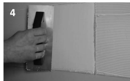
4. Posez les feuilles de mosaïque, filet vers le bas, fermement sur le matériel de fixation fraîchement étalé. Utilisez des feuilles de mosaïque de différentes boîtes pour une variation régulière. En utilisant une taloche en caoutchouc ou un outil équivalent, enfoncez doucement le carreau dans l'adhésif pour vous assurer d'une adhérence uniforme. Des cales d'espacement peuvent être utilisées pour garder une distance fixe entre les carreaux muraux en mosaïque.
