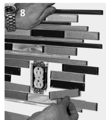
6. Une fois l'installation terminée, il peut être nécessaire d'installer une rallonge de boîte électrique (qui se trouve chez votre quincailler) autour des prises ou interrupteurs. Ceci permettra à la plaque électrique de reposer à plat contre les carreaux. **Assurez-vous que l'alimentation électrique est coupée** lorsque vous installez la rallonge de boîte électrique et suivez les instructions d'installation du fabricant ou consultez votre électricien.
